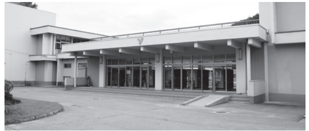
改築前の昇降口
