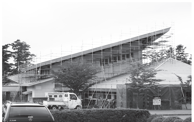
パレス松風の改修状況
