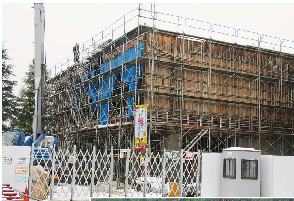
統合中学校 昇降口増築工事
