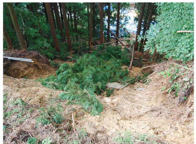
復旧を待つ 箕和田急傾斜面崩壊現場
