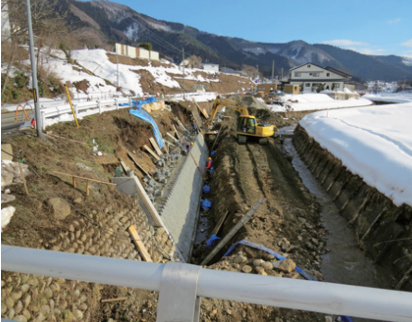
貝生地区の災害復旧現場
