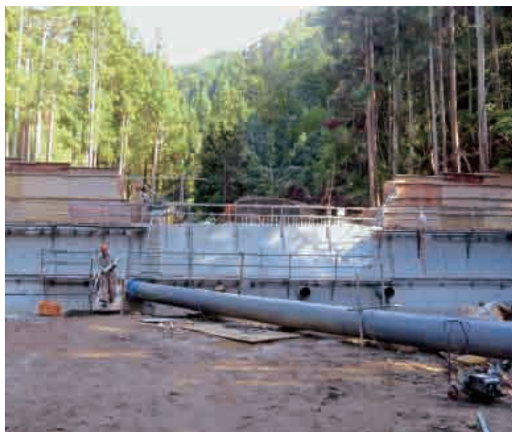
整備が進む貝生地区砂防ダム
