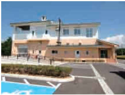
汚泥再生処理センター（長井市）
