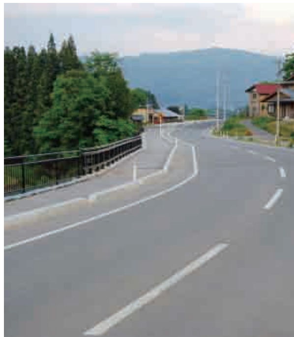
完成した赤坂深山線（深山地内）
