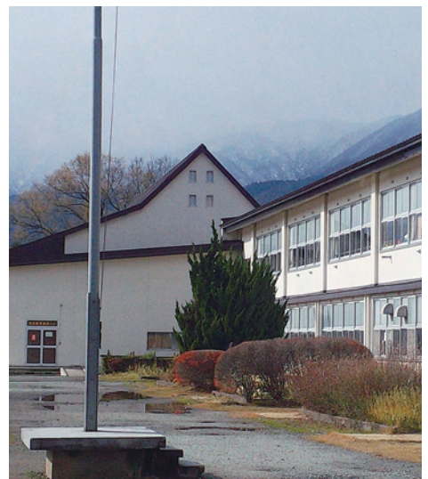
旧西中、解体されるの？
