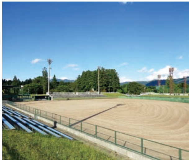
改修されるソフトボール場
