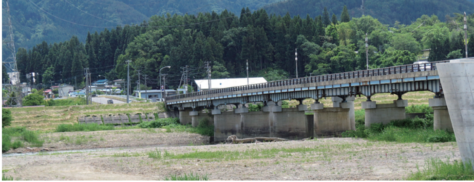
橋脚の完成を待つ
