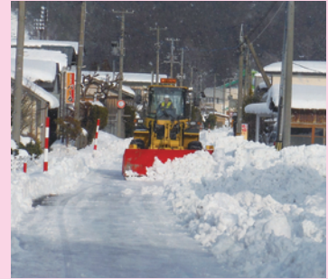
拡幅除雪作業
