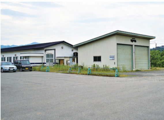
解体を待つ機械保管庫
