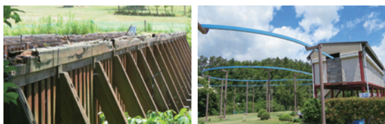
補修を待つ施設
