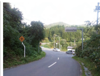
斜面に挟まれた国道の入口
