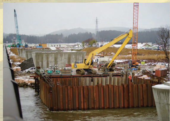
完成が待ち遠しい新荒砥橋 (2021年4月開通予定)
