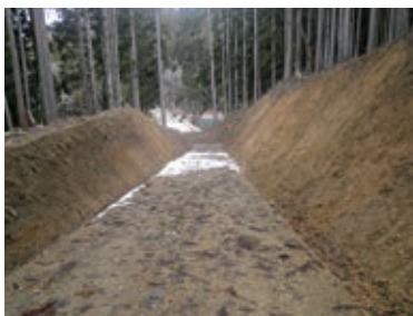
整備された工事用道路
