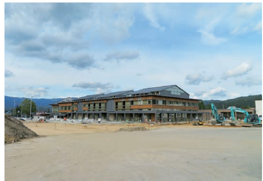
進む外構工事
