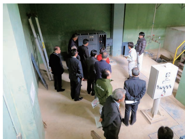
被災した白鷹揚水機場の視察
