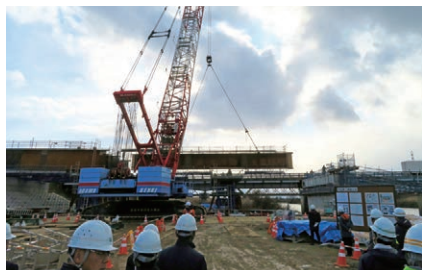
巨大クレーンで建設中
