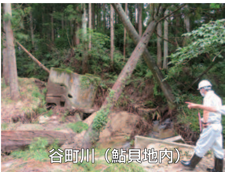
実淵川鮎貝堰頭首工付近
