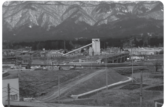
秋の開通に向けて順調に進められているしらたか大橋（仮称）の工事。川西地区にとっては待望の開通となります。
