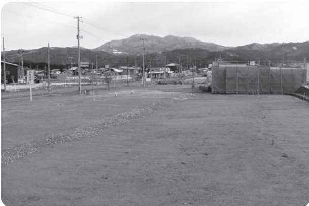
春の桜シーズンに合わせてオープンする交流商業施設の工事も着々と進められています。
