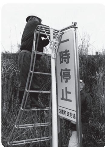
看板の取り付け作業を行う、正副支部長
