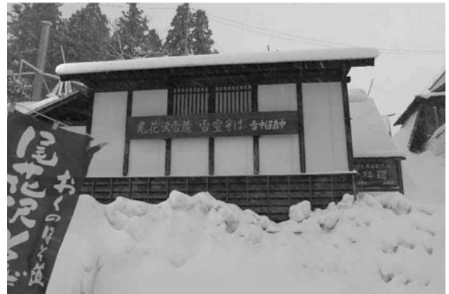
明友庵(雪冷熱利用貯蔵施設)
