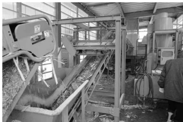
木質チップ製造施設
