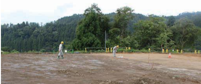
整地面確認中
