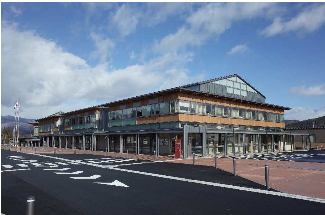
白鷹町まちづくり複合施設（白鷹町産材使用施設）
