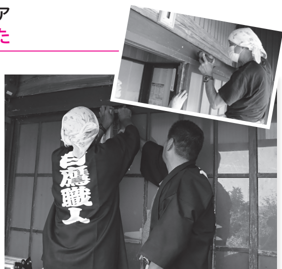
玄関引き戸の修理、丁寧に作業を進めていただきました。
