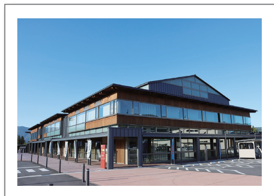
まちづくり複合施設の完成 （令和 2 年 10 月撮影）
