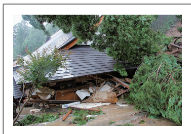
2 年連続で発生した豪雨災害 （平成 26 年 7 月撮影）
