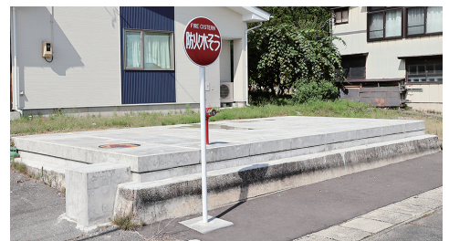
蓋がけした防火水槽
