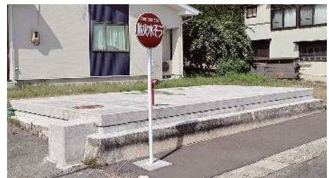
蓋がけした防火水槽
