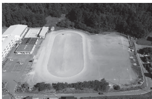
白鷹中学校グラウンドの排水対策を実施
