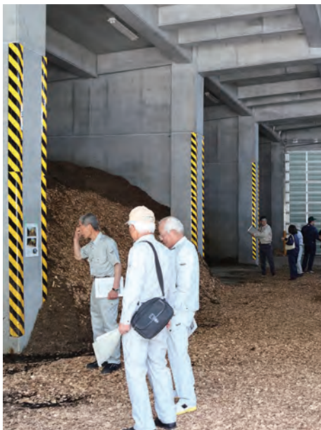
福島県飯館村の処理施設
