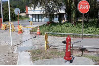
道路工事で移設
