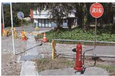
道路工事で移設
