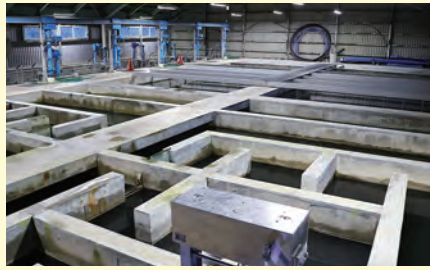
津島台浄水場の沈殿槽
