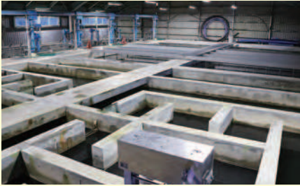
津島台浄水場の沈殿槽
