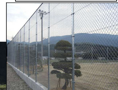
外周フェンス: 施工イメージ
