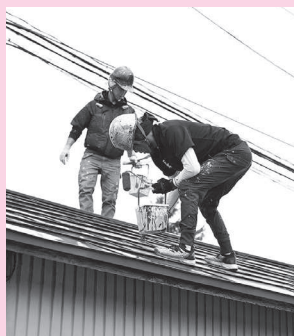
物置小屋屋根の塗装（蚕桑小）
