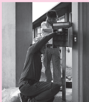
正面玄関ポスト修繕（専修学校）
