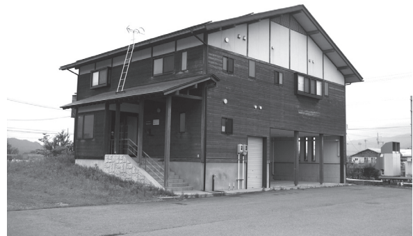
入居を募集する施設(Aタイプ)の外観
