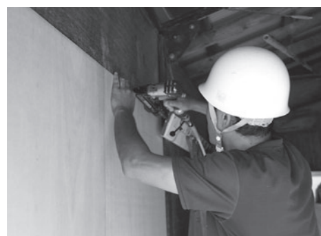
荒砥小学校の石灰小屋内部のベニヤ板を手際よく張り替える建設組合員
