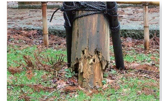
取替前の支柱
