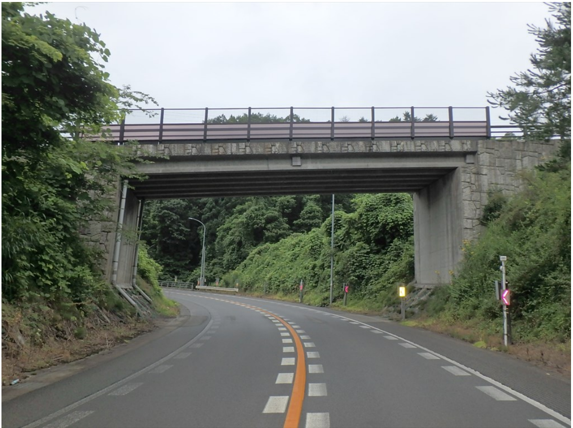
細野前田橋（町道 荒砥細野線 平成3年架設）
