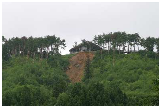
H25年7月豪雨による被災状況（パレス松風付近）
