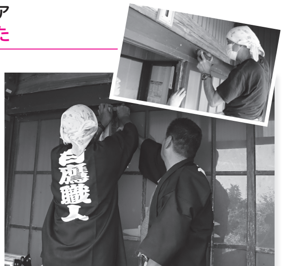
玄関引き戸の修理、丁寧に作業を進めていただきました。
