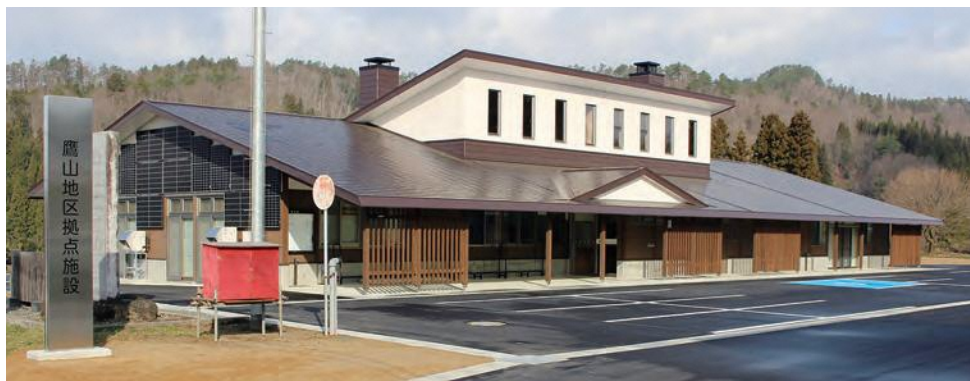
鷹山地区拠点施設（白鷹の杜 たかやま） 正面
