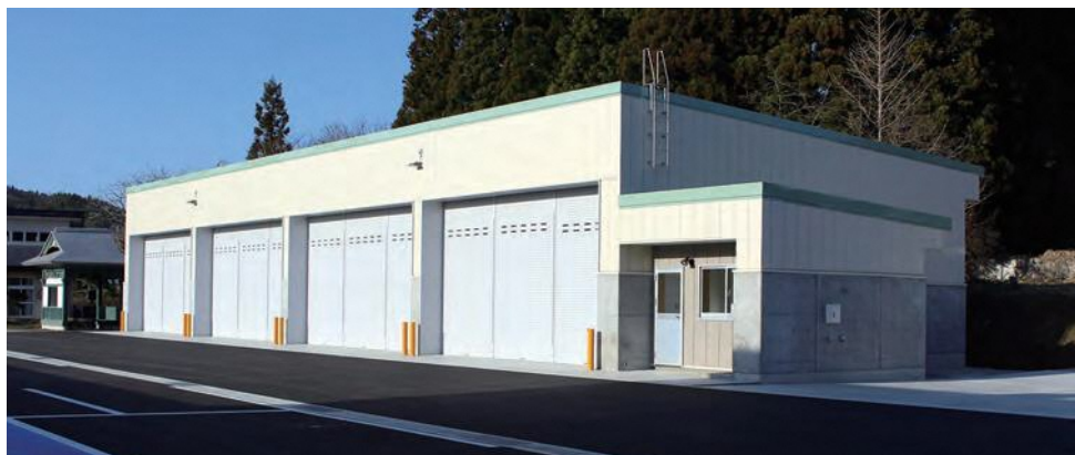
除雪機械格納庫 正面
