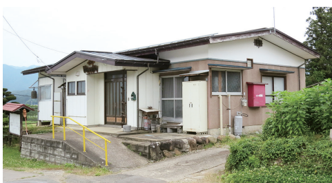
屋根を改修した荒砥新町分館
