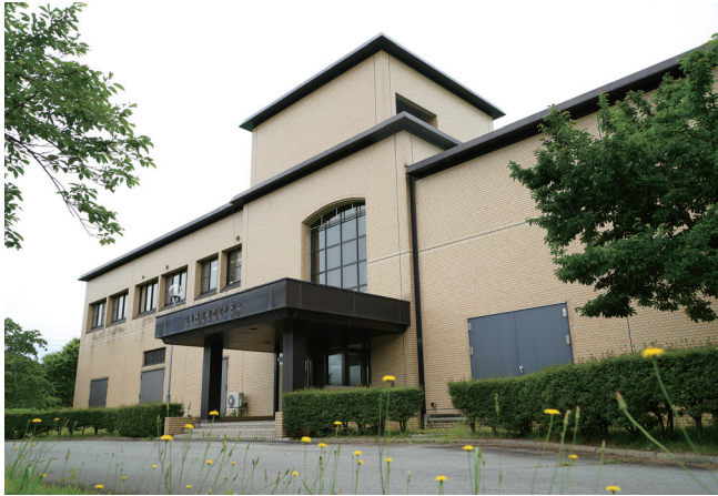
下水道インフラの要、浄化管理センター
